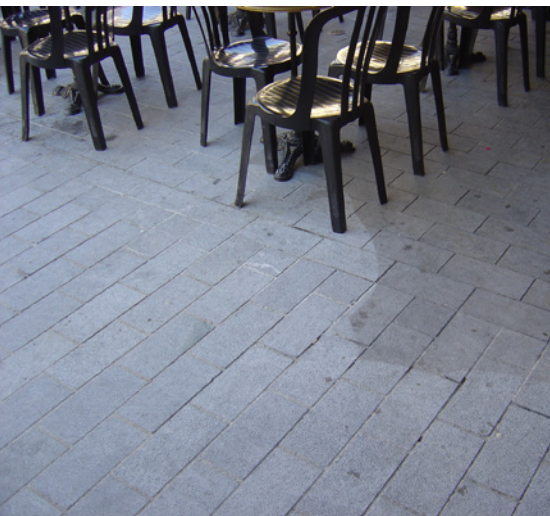
Dalles granite place Saint-André à Grenoble
