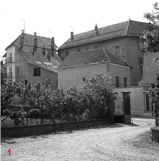
1985. Roucaute, Gérard. Parcelle 616. Ce bâtiment réputé être l'ancien château de Lesdiguières comporte une demi-croisée.
