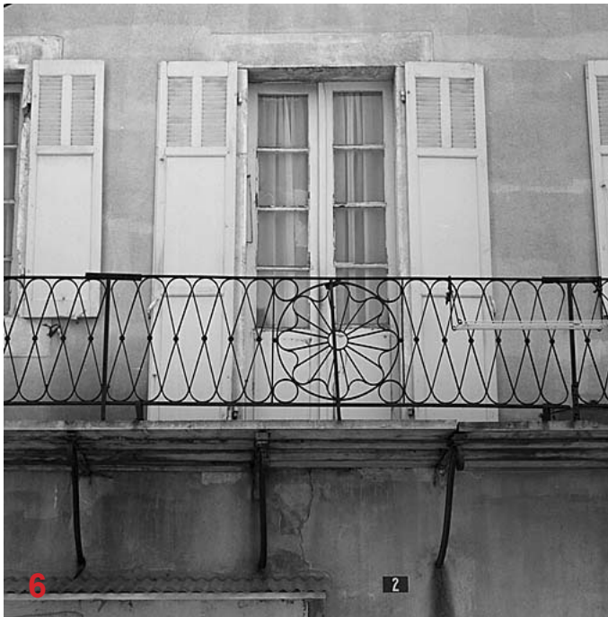
1985. Roucaute, Gérard. Maison place aux Herbes (parcelle 698). Garde-corps de balcon en ferronnerie, détail.
