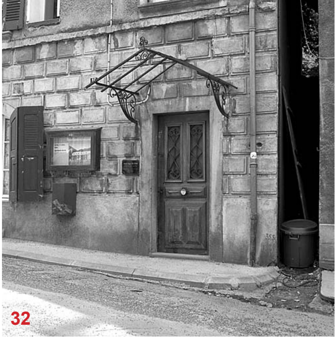
S 1985. Roucaute, Gérard. Maison rue de Chaillol (parcelle 912). Faux bossage façonné dans l'enduit et auvent en ferronnerie autrefois vitré.
