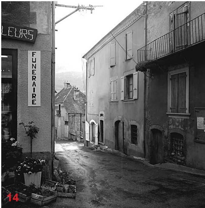
1985. Heller, Marc. 17 rue des Maréchaux. Vue d’ensemble de l’élévation antérieure.
