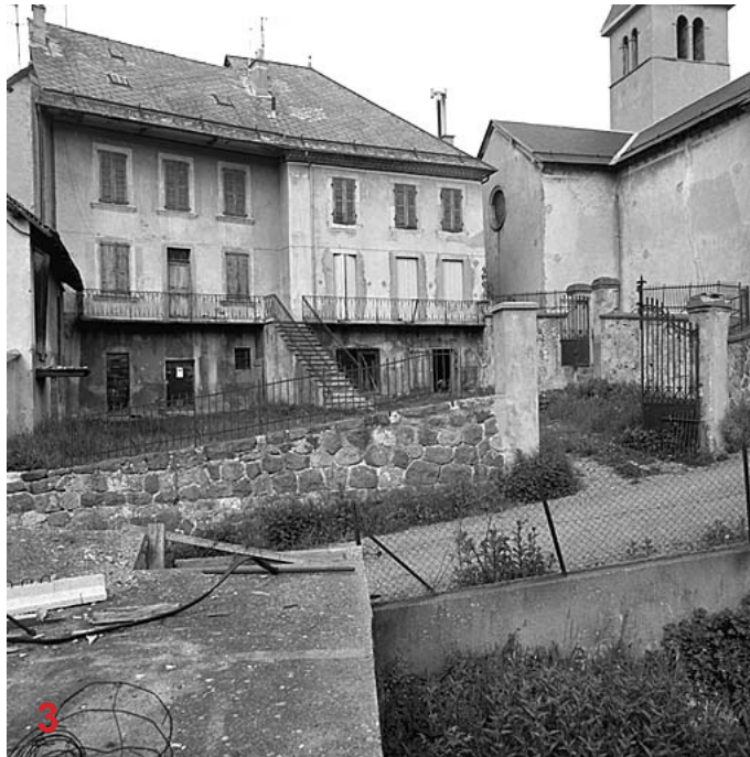
1985. Roucaute, Gérard. Maison rue de l'Eglise (parcelle 609). Vue prise de l'est.
