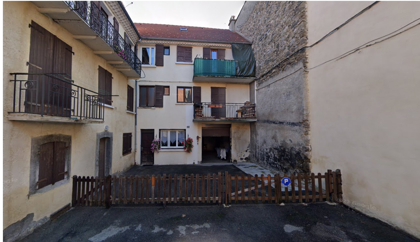
2. Ancien jardin privé, aujourd'hui imperméabilisé. La clôture, en retrait par rapport à la limite cadastrale met à disposition une partie de la parcelle pour le stationnement automobile des riverains
