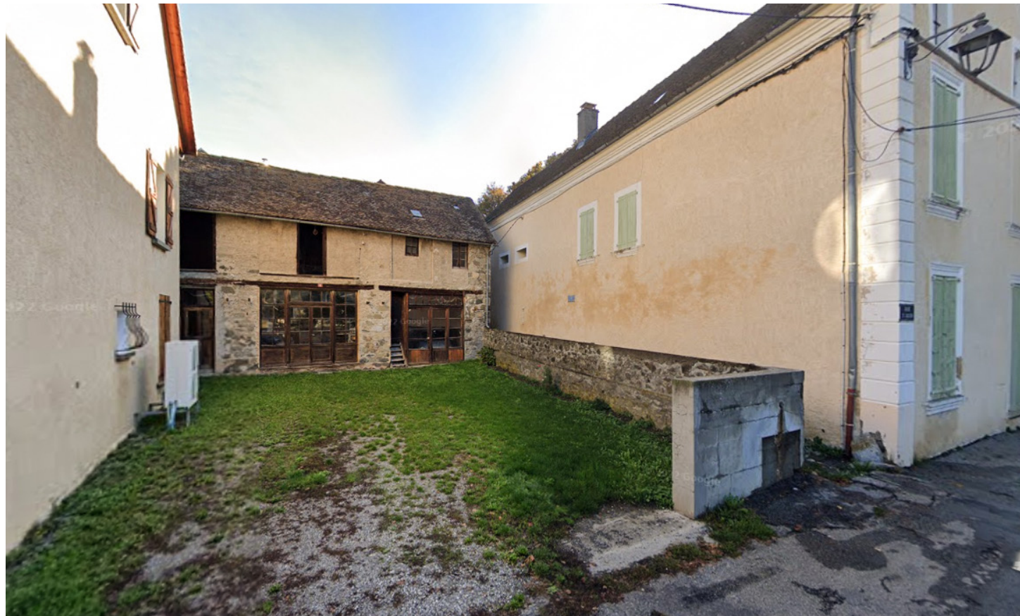
4. Croisement entre l'ancien chemin de Saint-Julien et d'une venelle. Traces d'une fontaine aujourd'hui disparue
