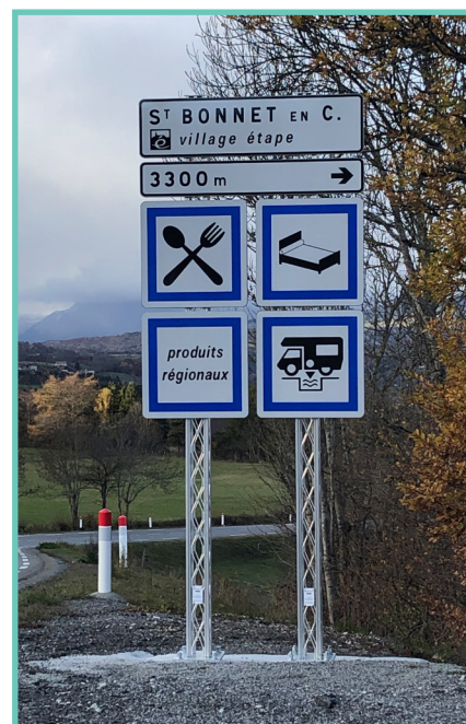
Installation d'un nouveau panneau routier sur la N85
