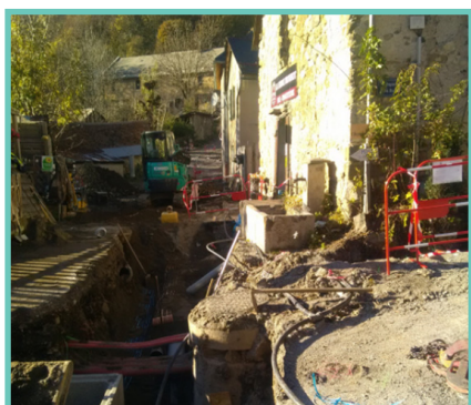
En cours de réalisation, Les Infournas Haut
